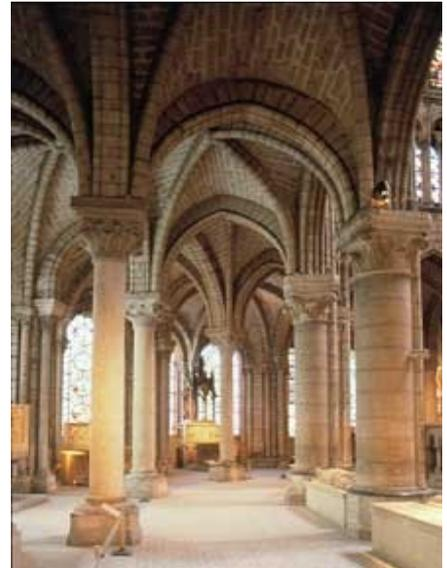
Découvrez comment le gothique résous les problèmes technologiques insurmontables pour l'époque : l'élévation en hauteur des bâtiments, remplacement des murs par des vitraux, qui sont aujourd'hui les plus vieux de France et contrebutement des pressions.
